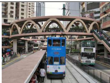
圖 5. 香港銅鑼灣天橋
